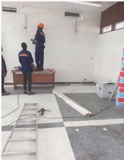
CDI 7: Renovation of office space given to AFROHUN Côte d'Ivoire. Photo source: AFROHUN Côte d'Ivoire.
